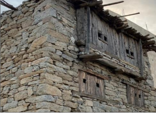
صورة رقم (٨): نماذج من النوافذ في عمارة المنزل منزل من قها ثقيف.
